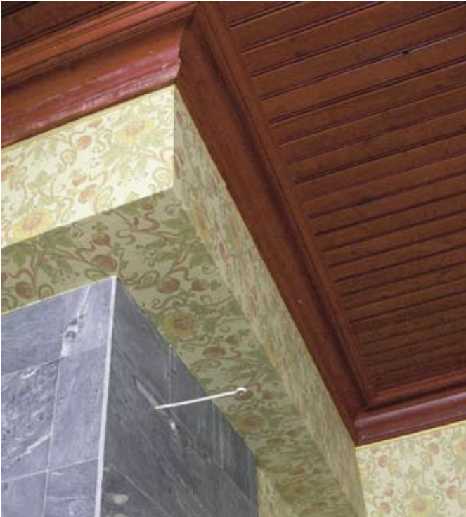
Alkuperäinen katto ja leveät listat paljastuivat sisäkattolevyjen alta.
