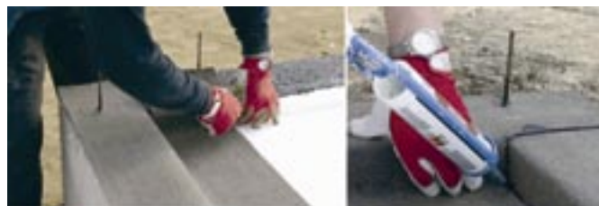
Kuva 5: Bitumikermien asentaminen perusmuurin päälle ja nurkkaliitoksen tiivistäminen. Kuvat: Katopal Oy.
