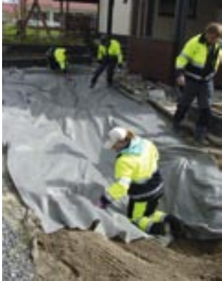
Allaskumin alle tulee pehmentävä suodatinkangas.
