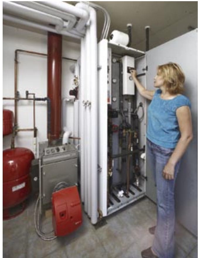
Aurinkolämpöjärjestelmässä toiminnot hoituvat automaattisesti antureiden ja ohjausyksikön käskystä. Säätimen näytöstä voi lukea antureiden lämpötilat.
