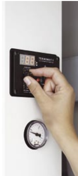
Aurinkolämpöjärjestelmässä toiminnot hoituvat automaattisesti antureiden ja ohjausyksikön käskystä. Säätimen näytöstä voi lukea antureiden lämpötilat.
