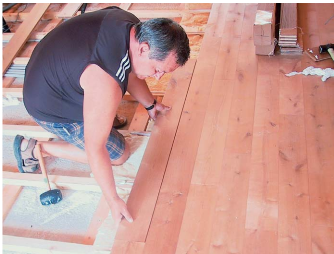
20 mm sandwich-rakenteiset Kp-floors massiivipuulattian asennus suoraan niskojen päälle liimamassalla.
