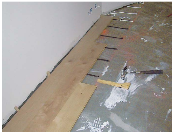
15 mm lattiat voidaan asentaa joko uivana tai liimamassalla suoraan kuivan, käsitellyn betoni- tai muun kantavan lattian päälle.
