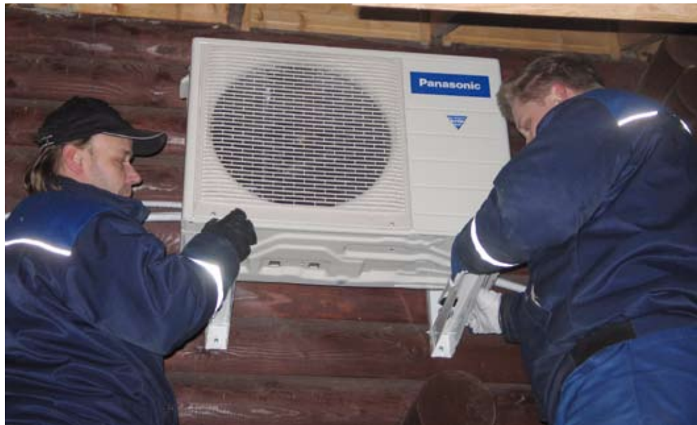
Ilmalämpöpumpun asentaminen on ammattimiehen hommaa. Aikaa siihen kuluu lähes työpäivä.
