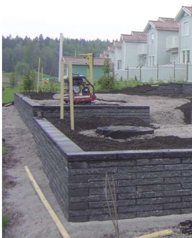
Viittävä rinnetontti porrastetaan käytännöllisiksi terasseiksi betonisten muurikivien avulla.
