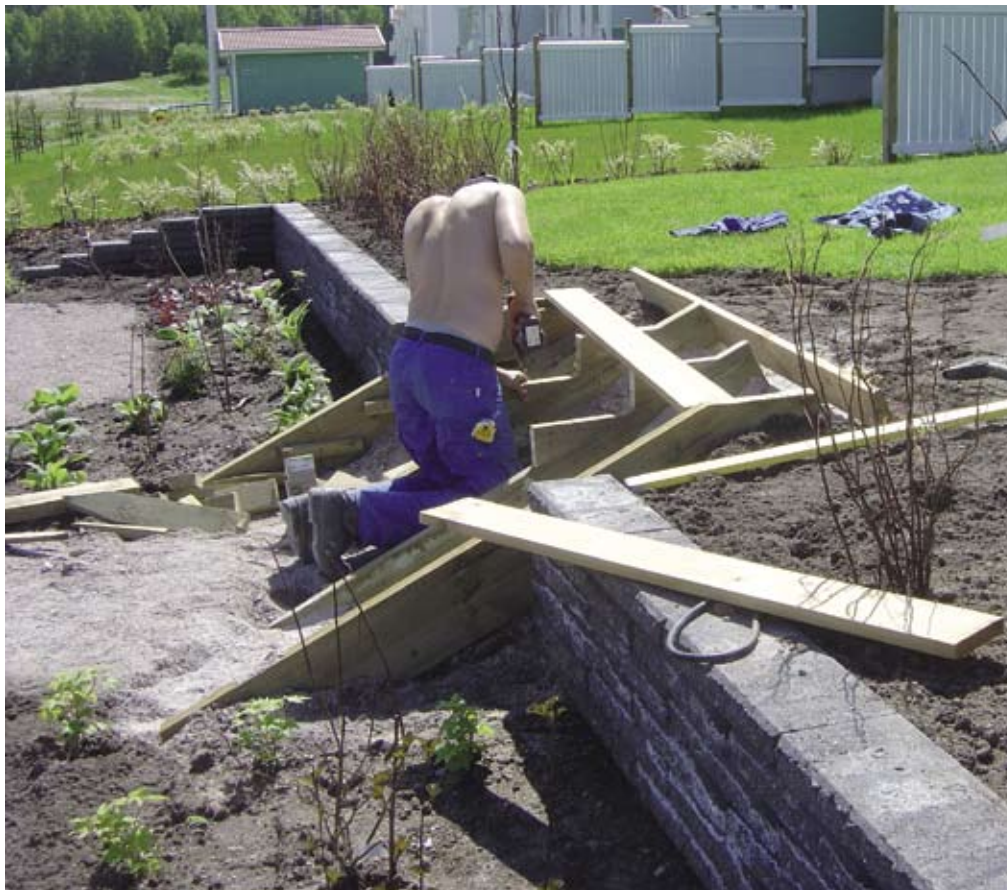
Pihan puiset porraskeskelet rakennetaan loppuvaiheessa kun muurit, kasvualustat, istutustyöt ja siirtonurmen asennus ovat valmiina.
